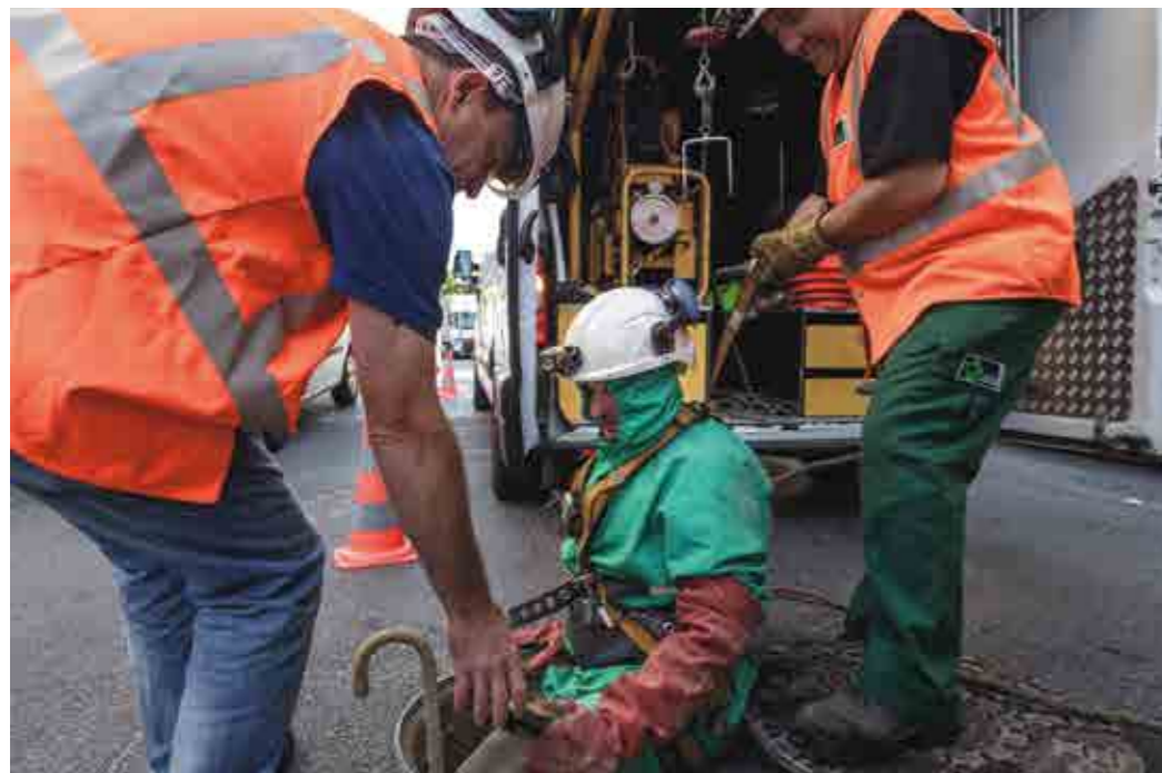
Ci-contre L'entretien des réseaux, des opérations délicates et essentielles. (Aubervilliers)
