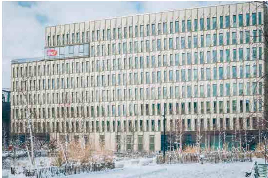
Ci-contre Bureaux de la SNCF réseaux avenue des fruitiers
