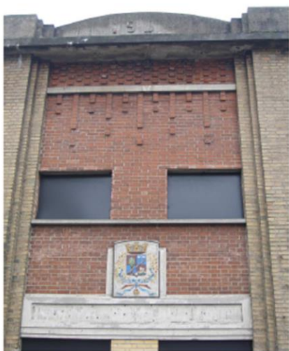
Détail de calepin des bains-douches
