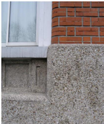
Détail de la variété des matériaux mis en oeuvre sur le collège Poincaré
