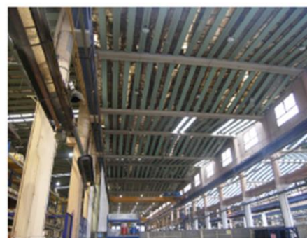
Halle en béton armé d'Alstom
