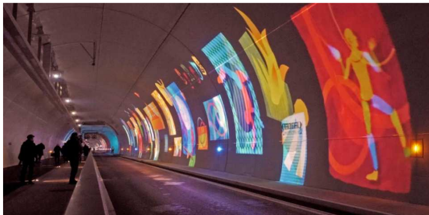
Figure 68 : Tunnel « mode doux » de la Croix Rousse, Lyon (source : culturebox.francetvinfo.fr )
