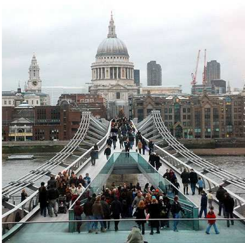
Figure 63 : Millénium bridge, Londres (source : routard.com)
