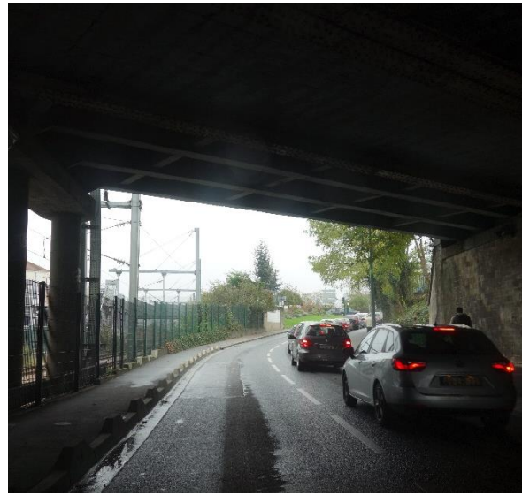
Passage sous les voies de la grande ceinture à Epinay
