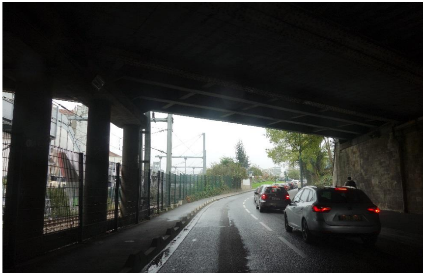
Passage sous les voies de la grande ceinture à Epinay
