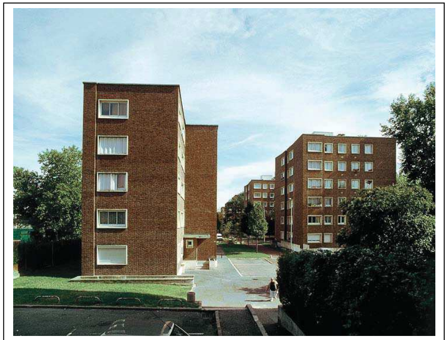
Les deux typologies de bâtiments, barres à droite et plot à gauche. Photographie J.B. Vialles Département de la Seine-Saint-Denis / Région Île-de-France, ADAPG, 2008
