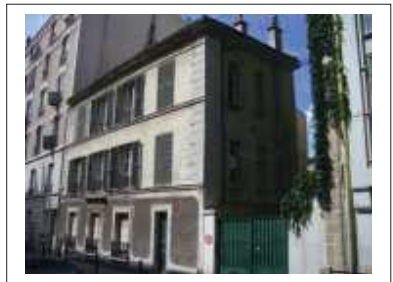
Façade sur rue de la maison Département de la Seine-Saint-Denis, DCPSL, SPC
