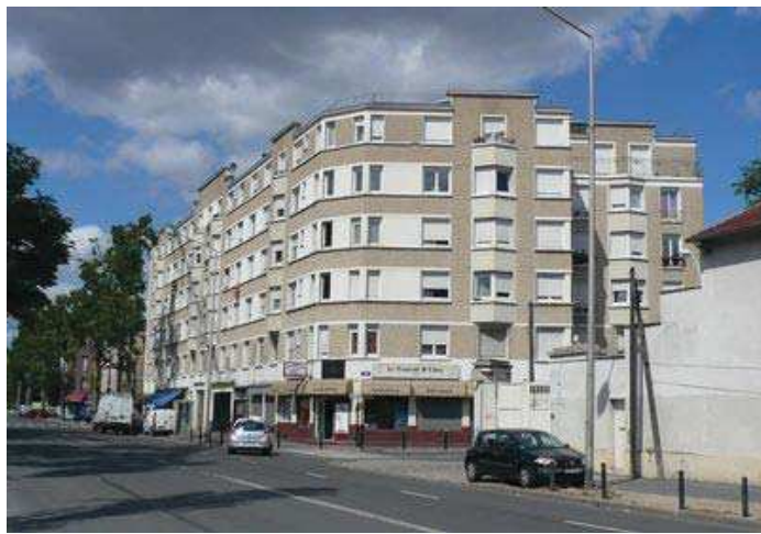
Vue d'ensemble boulevard de la libération. Département de la Seine-Saint-Denis, DCPSL, SPC
