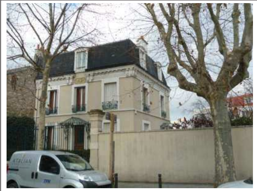
Façades sud et est et clôture depuis l'avenue Albert Einstein. On peut apercevoir sur la façade latérale une marquise correspondant peut-être à une autre entrée. Département de la Seine-Saint-Denis, DCPSL, SPC
