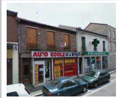
38 bis et 38 rue Henri Barbusse. Au second plan, la façade du N°38 a été modifiée. Département de la Seine-Saint-Denis, DCPSL, SPC
