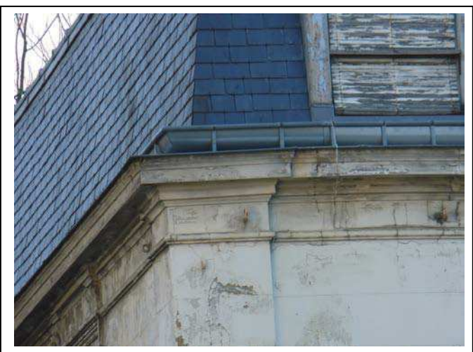
Ci-dessus et de haut en bas : vues générales et vue de détail Département de la Seine-Saint-Denis, DCPSL, SPC
