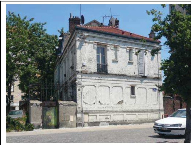
3 quai du Port : située près du canal, cette maison fait partie de la villa Danré (voir plan de 1900). Contrairement aux autres maisons de la villa, celle-ci possédait 2 entrées situées de part et d'autre de cette façade (une est aujourd'hui condamnée). Elle a en outre conservé sa clôture d'origine côté voie et sa jolie grille côté canal. Département de la Seine-Saint-Denis, DCPSL, SPC
