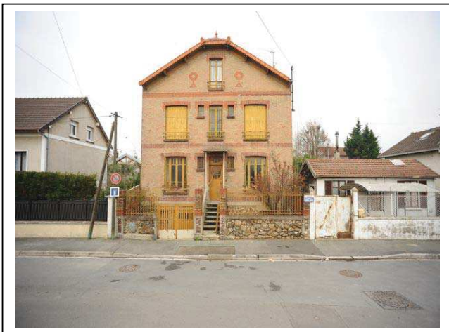
Ci-dessus : façade sur rue Jacques MANGIN – UASD – Département de la Seine-Saint-Denis
