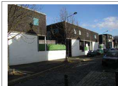
Les logements individuels rue Prairial. Département de la Seine-Saint-Denis, DCPSL, SPC
