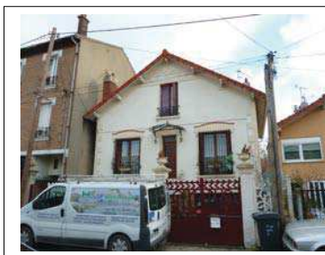
16 (en haut) et 7 (en bas) rue des Muguets Département de la Seine-Saint-Denis, DCPSL, SPC
