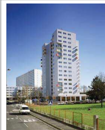
Vue de la tour, au premier plan, l'espace vert du groupe scolaire. Photographie de S. Asseline Département de la Seine-Saint-Denis / Région Île-de-France, ADAPG, 2003
