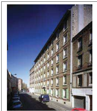
Façade sur rue Département de la Seine-Saint-Denis, DCPSL, SPC
