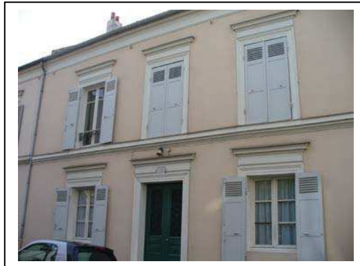
ci-contre à gauche : 22, 20 et 18 rue Pinel ci-contre à droite : 18 rue Pinel Département de la Seine-Saint-Denis, DCPSL
