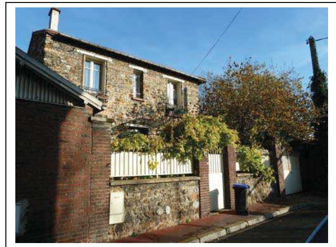
Façade sur rue avec à gauche hangar en brique
