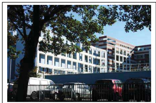
Depuis le mail piéton Département de la Seine-Saint-Denis, DCPSL, SPC
