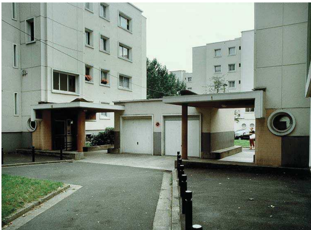
Entrée d'une des tours. Photographies J.B. Vialles Département de la Seine-Saint-Denis / Région Île-de-France, ADAPG, 2008
