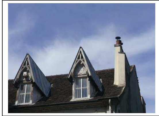
Vue des lucarnes façade rue Emile Connoy Département de la Seine-Saint-Denis, DCPSL, SPC
