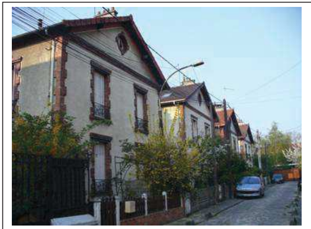
Ci-dessus : maisons doubles coté sud Département de la Seine-Saint-Denis, DCPSL, SPC Ci-contre : détail des clôtures, maisons doubles, côté nord
