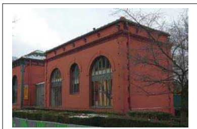
Ancien local sanitaire-réfectoire (G1). Façade sur l'avenue des Magasin Généraux. Département de la Seine-Saint-Denis, DCPSL, SPC
