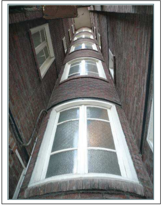
Détail de la tour d'escalier sur cour. Département de la Seine-Saint-Denis, DCPSL, SPC
