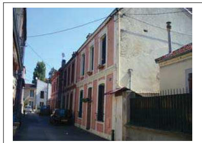
Les trois façades sur l'impasse. Département de la Seine-Saint-Denis, DCPSL, SPC
