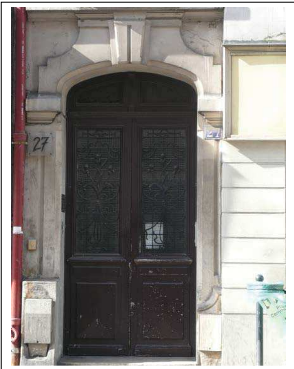
ci-dessus : le détail de la porte d'entrée, de la qualité de l'huiserie et de l'encadrement. ci-dessous : la détail du décor de brique et de l'éclairage public mal intégré à la façade. Département de la Seine-Saint-Denis, DCPSL, SPC
