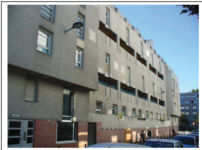
Façade rue des Moulins Gémeaux, avec sa distribution par coursives, et ses parties saillantes. Département de la Seine-Saint-Denis, DCPSL, SPC
