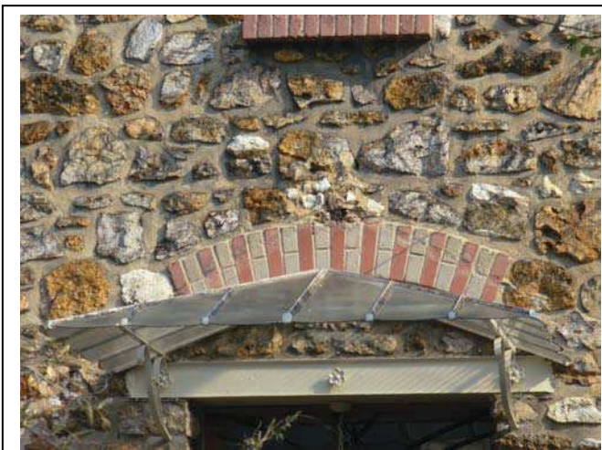
Détail de la marquise
