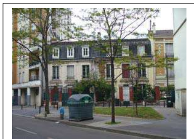
14 et 12 villa Danré Département de la Seine-Saint-Denis, DCPSL, SPC / Jacques MANGIN - UASD
