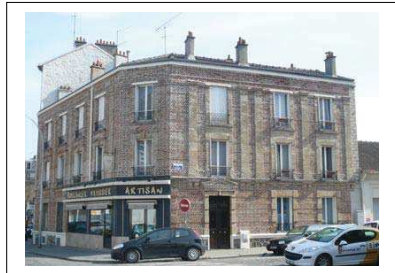
Façades sur rue
