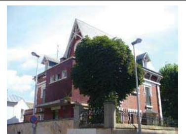
Vue de la maison à l'angle des rues Gibault et Franklin. Département de la Seine-Saint-Denis, DCPSL, SPC
