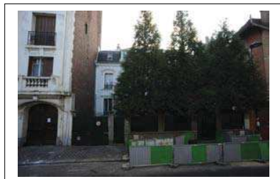
Façade sur rue Département de la Seine-Saint-Denis, DCPSL, SPC / Jacques MANGIN - IIAST
