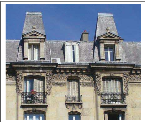
Le couronnement des bow-windows et du décor sculpté foisonnant (motifs de lierre à fruits). On remarque ici parfaitement l'altération visuelle que constitue le système de climatisation. Département de la Seine-Saint-Denis, DCPSL, SPC
