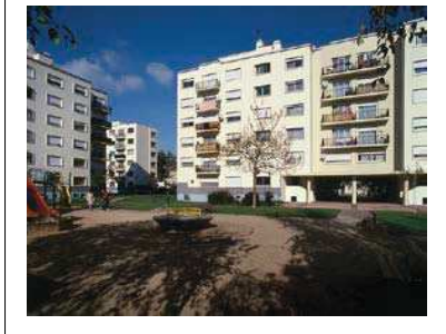
Façades sur cour Photographie J.B. Vialles, Département de la Seine-Saint-Denis / Région Ile-de-France, ADAPG, 2008.
