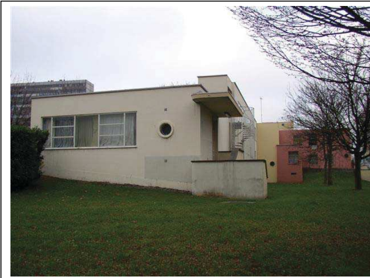
Le groupe scolaire des Cosmonautes, côté rue de La Courneuve
