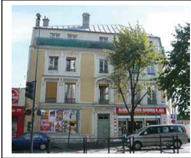
Façade sur le boulevard Marcel Sembat. Département de la Seine-Saint-Denis, DCPLS, SPC
