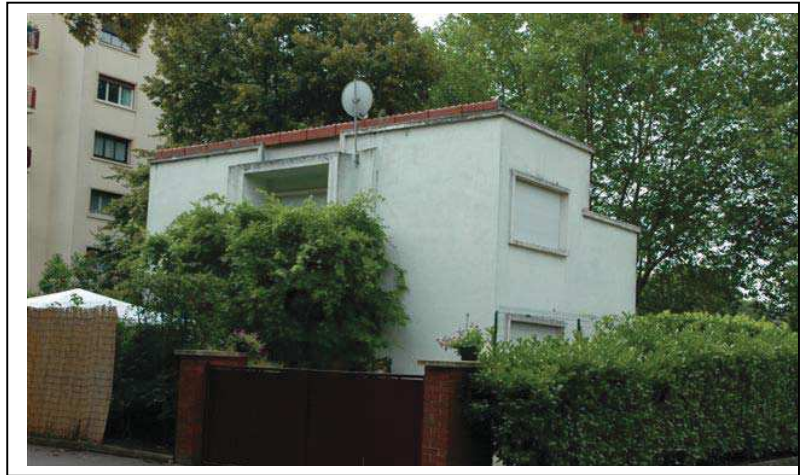
Le pavillon individuel. Département de la Seine-Saint-Denis, DCPSL, SPC
