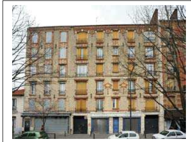
Immeubles 140 et 142, avenue du Président Wilson
