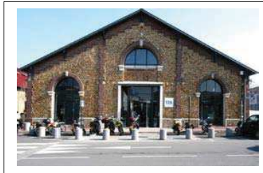
Pignon principal du magasin E et détail de la modénature. Département de la Seine-Saint-Denis, DCPSL, SPC
