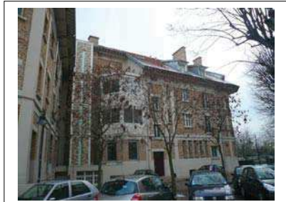
Façade arrière du bâtiment de bureau. Département de la Seine-Saint-Denis, DCPSSL, SPC
