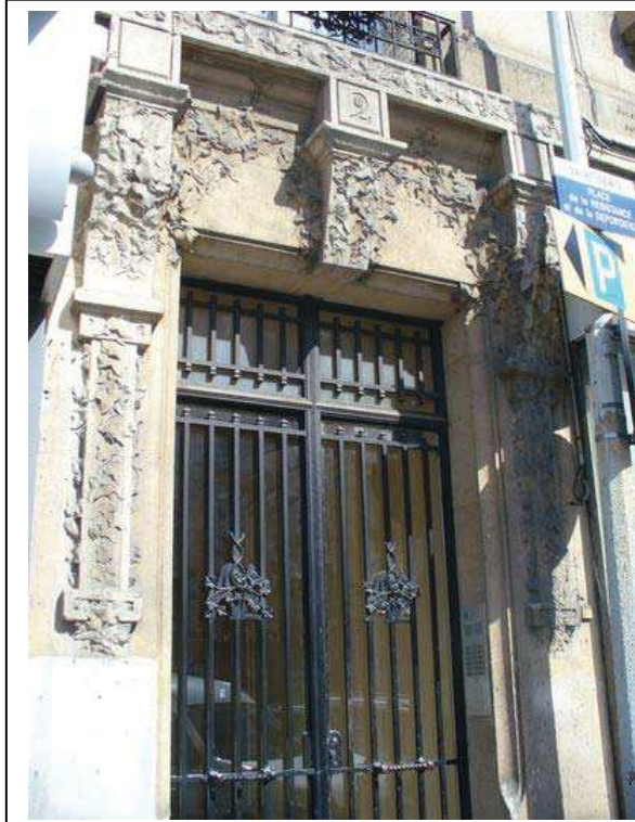
La porte d'entrée piétonne (au n°2) : le mobilier urbain et les devantures de boutiques saillantes nuisent à sa lisibilité. Département de la Seine-Saint-Denis, DCPSL, SPC
