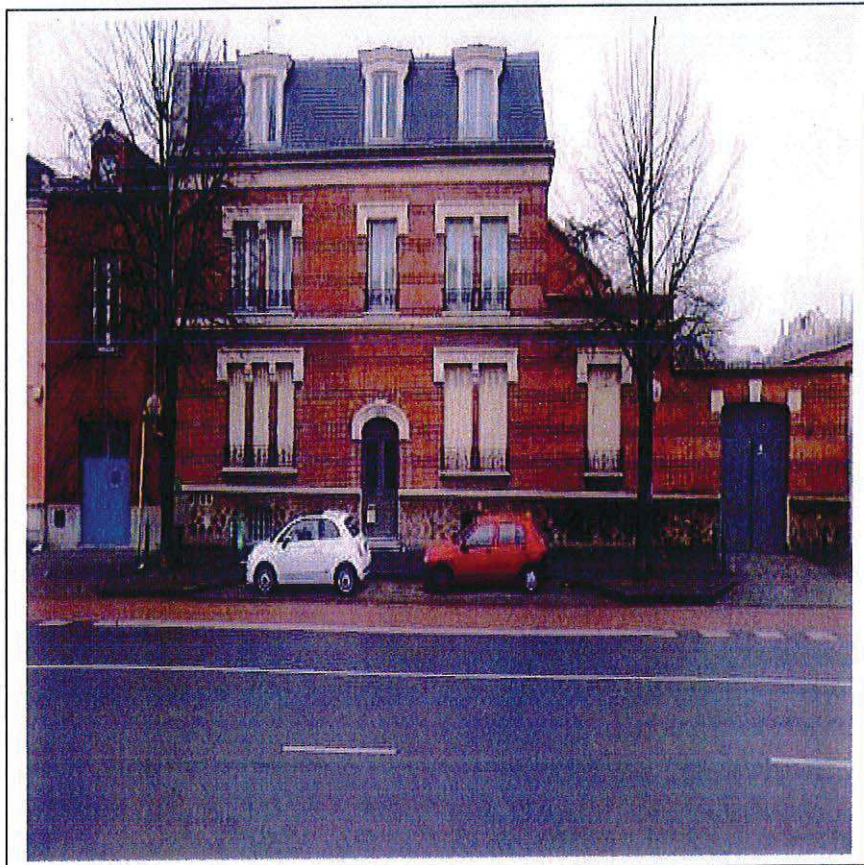
Haut et bas : vues de la façade sur le boulevard Département de la Seine-Saint-Denis, DCPSL, SPC © Jacques MANGIN – UASD – Département de la Seine-Saint-Denis
