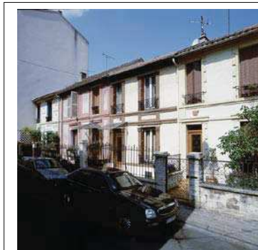
Façades sur rue E. Jacquot, Département de la Seine-Saint-Denis, DCPSL, SPC
