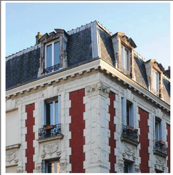
Le détail de la qualité des lucarnes. Département de la Seine-Saint-Denis, DCPSL, SPC
