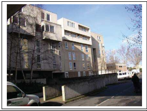
Rue Vendémiaire, à gauche les logements depuis le passage sous voûte et à droite, le bâtiment d'activités que fait barrage à l'avenue Département de la Seine-Saint-Denis, DCPSL, SPC
