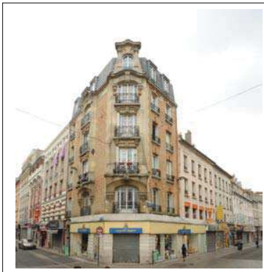
Façade sur rue Département de la Seine-Saint-Denis, DCPSL, SPC
