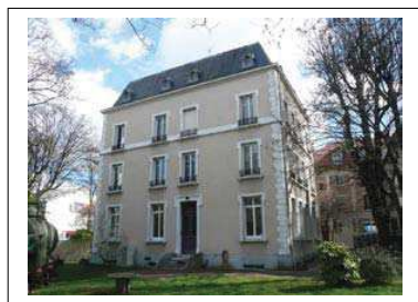
Façade arrière. Département de la Seine-Saint-Denis, DCPSL, SPC
