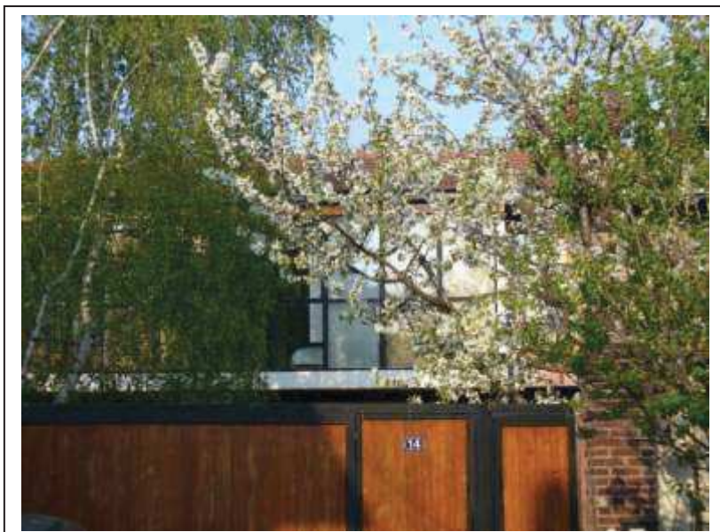
Ci-contre : bureaux et habitation situés au fond de l'impasse (anciens bureaux de l'entreprise Cartier Frères et surélévation postérieure ?) Département de la Seine-Saint-Denis, DCPSL, SPC
