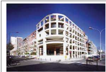
Façade sur rue S. Asseline, Département de la Seine-Saint-Denis / Région Île-de-France, ANACP 7 20113
