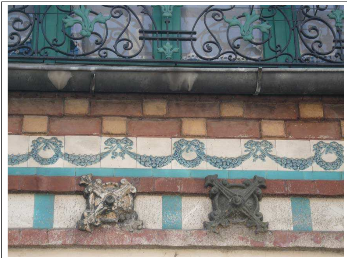
Détail de la céramique architecturale et des motifs bichromes en brique. Département de la Seine-Saint-Denis, DCPSL, SPC
