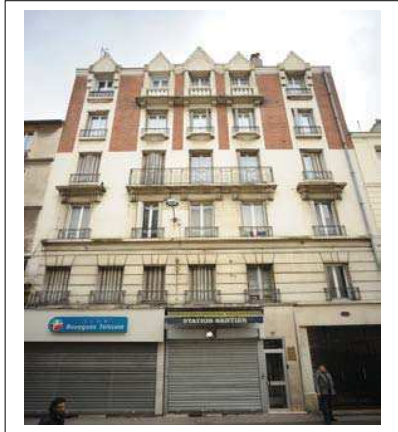
Façade sur rue Département de la Seine-Saint-Denis, DCPSL, SPC
