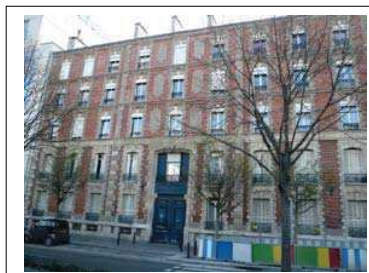
Façade sur rue Département de la Seine-Saint-Denis, DCPSL, SPC
