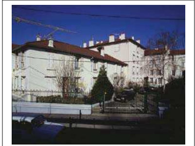
Façade sur rue Photographie de S. Asseline Département de la Seine-Saint-Denis / Région Île-de-France ADAPG 2003
