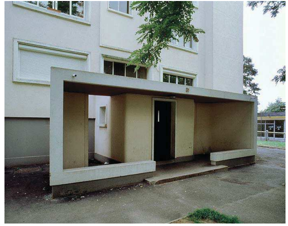
L'entrée de la tour ouest. Photographies J.B. Vialles Département de la Seine-Saint-Denis / Région Île-de-France, ADAPG, 2008
