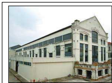
Vue oblique de la salle des machines, 2006 JB Vialles, Conseil régional d'Ile-de-France.
