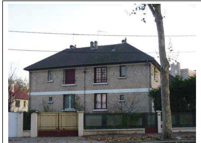
La maison n°32-34 avenue R. Rolland avant le remplacement de son portail (aujourd'hui en PVC) Département de la Seine-Saint-Denis, DCPSL, SPC
