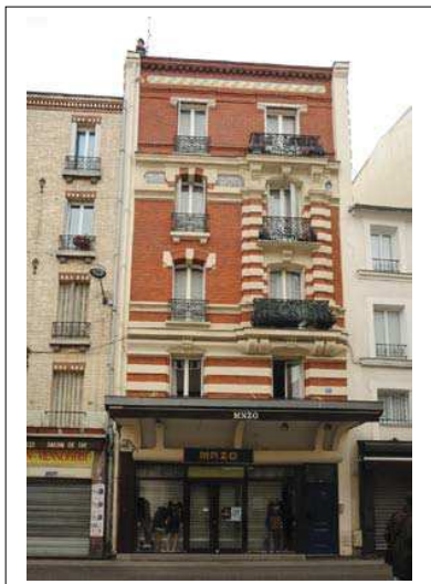
Façade sur rue Département de la Seine-Saint-Denis, DCPSL, SPC
