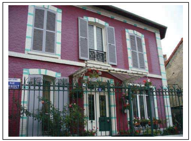
Détail de la façade rue Gibault Département de la Seine-Saint-Denis, DCPSL, SPC
