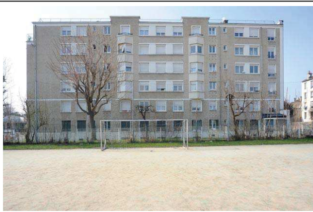
Vue depuis le square D. Fery. J. Manquin, UASD, Département de la Seine-Saint-Denis
