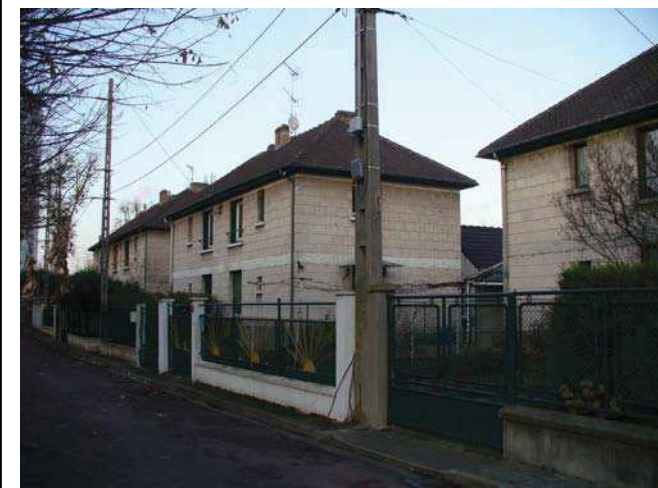
La villa des Tilleuls avec au 1 er plan une partie de la maison n°11, au 2 e plan la maison n°9-7 et au 3 e plan n° 5-3. Département de la Seine-Saint-Denis, DCPSL, SPC
