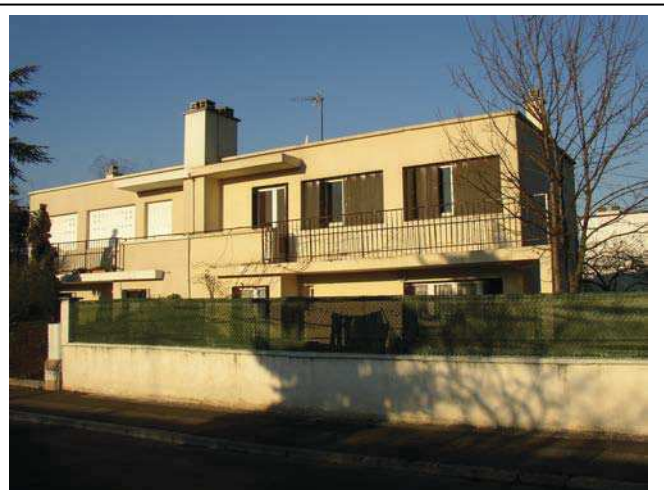
25 rue Yves Rousval -1 rue de Livry : Façade principale donnant sur la rue de Sevran. Le porte-à-faux entre le RDC et R + 1 a été surmonté d'une balustrade métallique afin de prolonger le balcon d'origine.
