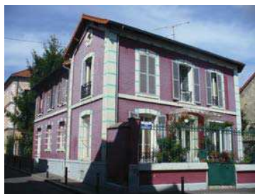
Vue de la maison à l'angle des rues Gibault et Franklin. Département de la Seine-Saint-Denis, DCPSL, SPC
