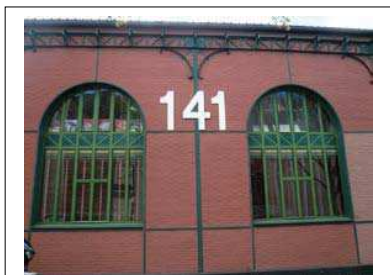
Détail des baies cintrées et des éléments de structure du groupe G2. Département de la Seine-Saint-Denis, DCPSL, SPC
