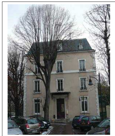
Façade principale Département de la Seine-Saint-Denis, DCPSL, SPC
