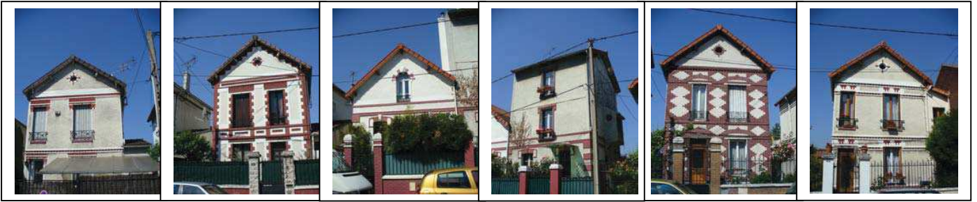
De gauche à droite : n°3,5,7,9 (surélevée), 11 et 11 bis rue Sorin. Département de la Seine-Saint-Denis, DCPSL, SPC
