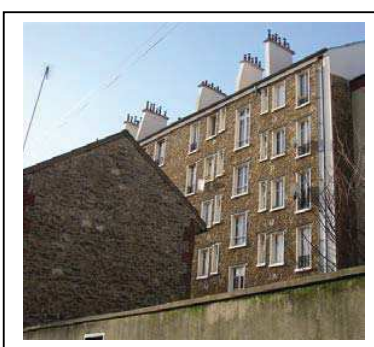
La façade arrière du bâtiment Département de la Seine-Saint-Denis, DCPSL, SPC
