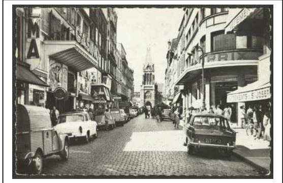
AD93 2 Fi Saint-Denis 972 : vue vers l'ouest sous le croisement avec la rue des Chaumettes (à droite), les magasins Uniprix. A gauche : le Cinéma Le Casino et le linéaire ancien homogène.
