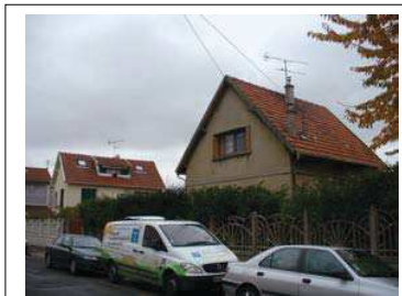
Façades sur rue des n°39 (1 er plan) et 37 (2 nd plan) Département de la Seine-Saint-Denis, DCPSL, SPC
