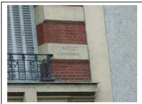
Plaque de l'entrepreneur et détail du garde-corps « Art Nouveau ». Département de la Seine-Saint-Denis, DCPSL, SPC
