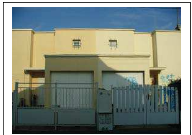
6-8 rue Marcel Croxo Département de la Seine-Saint-Denis, DCPSL, SPC
