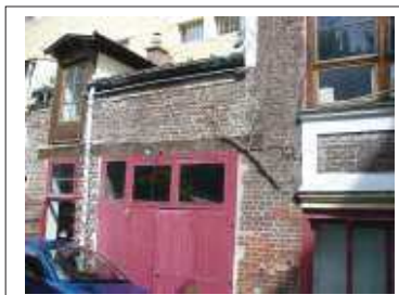
Porte cochère située en fond de parcelle du bâtiment de l'agence Département de la Seine-Saint-Denis, DCPSL, SPC
