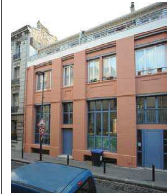
Façade sur rue J. Mangin, UASD - Département de la Seine-Saint-Denis
