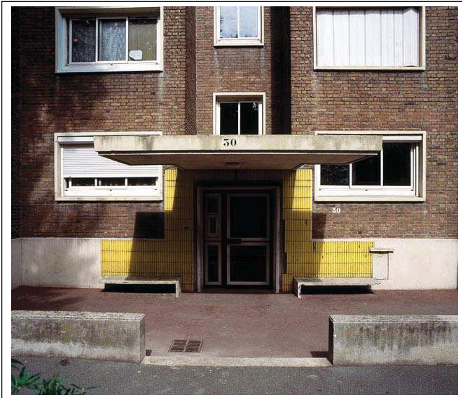
Une entrée d'immeuble avec céramique jaune et banc intégré d'origine.
