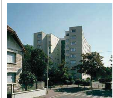
Façades sur rue.
