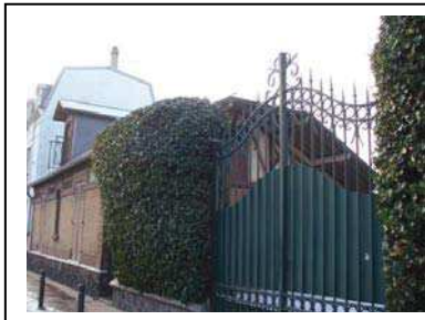
Vue du pavillon située à gauche de l'entrée Département de la Seine-Saint-Denis, DCPSL, SPC
