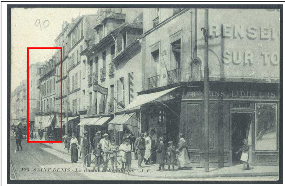
Carte postale, 2 Fi Saint-Denis 1020 : cette vue datée d'avant 1917, c.1900 ?, est prise depuis la place Jean Jaurès vers l'Ouest et montre les caractéristiques du bâti en bordure de l'îlot Haguette au début du XX e siècle : une architecture de l'époque Moderne ou médiévale aux façades étroites. Au bout de cette perspective, on remarque le 20 rue de la République (cadre rouge).
