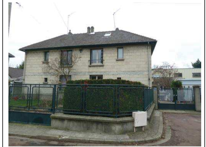
Maison n°11-13 (mêmes modèles que les maisons n° 32-34 av R. Rolland et n°3 à 9 villa des Tilleuls). Département de la Seine-Saint-Denis, DCPSL, SPC
