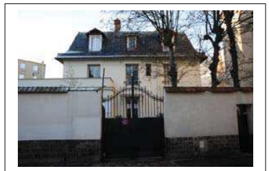
Façade sur rue Département de la Seine-Saint-Denis, DCPSL, SPC / Jacques MANGIN – IIA/SPD
