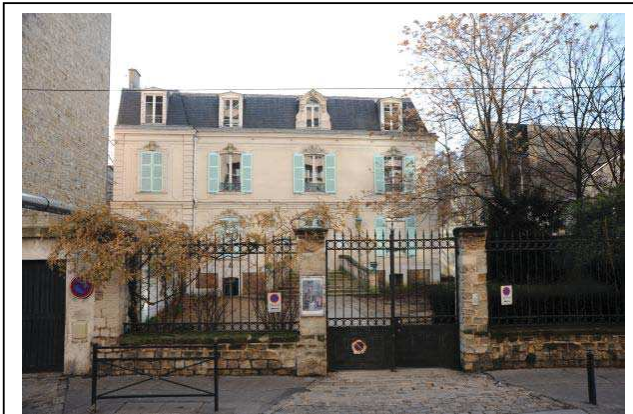
Ci-dessus: façades sur la rue A. Poullain Département de la Seine-Saint-Denis, DCPSL, SPC
