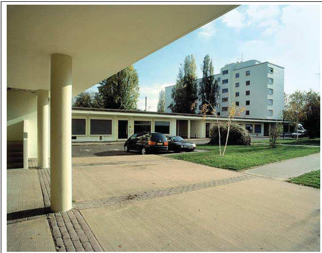
Les bâtiments des commerces joignant deux immeubles et créant ainsi une petite place au cœur de la cité. Photographies J.B. Vialles Département de la Seine-Saint-Denis / Région Île-de-France, ADAPG, 2008.
