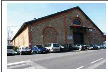
Pignon arrière du magasin D et détails de la modénature. Département de la Seine-Saint-Denis, DCPSL, SPC
