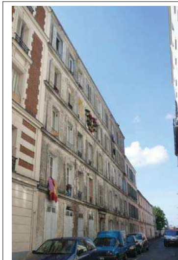
Façade sur rue Département de la Seine-Saint-Denis, DCPSL, SPC
