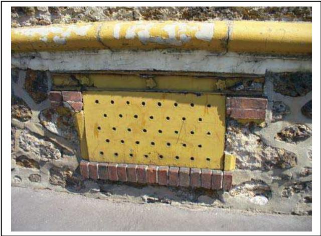
Détail du soupirail droit Département de la Seine-Saint-Denis, DCPSL, SPC
