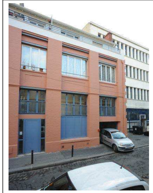
Le sous-sol de l'Avenir social était suffisamment vaste pour se transformer en parking souterrain. J. Mangin UASD - Département de la Seine-Saint-Denis
