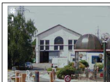
Vue arrière de la salle des machines, 2010
