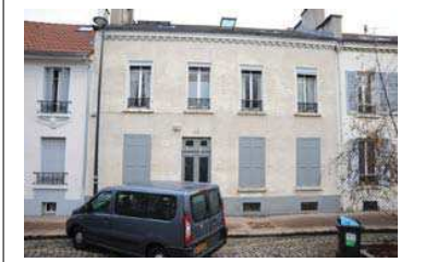
De haut en bas : façades du 15 et du 17 © Jacques MANGIN – UASD – Département de la Seine-Saint-Denis
