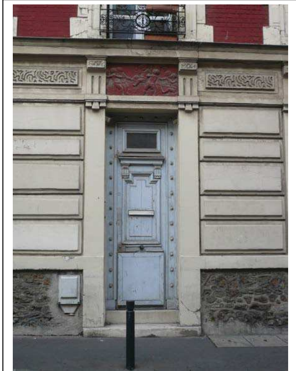
Le détail de la porte d'entrée.
