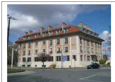
Les façades principales des bureaux, 2010. Département de la Seine-Saint-Denis, DCPSSL, SPC
