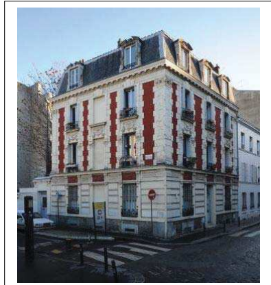
Façades sur rues © Jacques MANGIN – UASD – Département de la Seine-Saint-Denis
