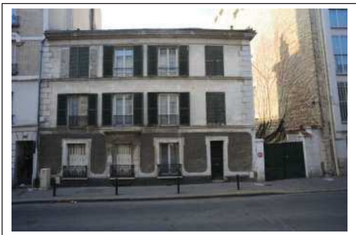
Façade de la maison depuis la rue Département de la Seine-Saint-Denis, DCPSL_SPC / Jacques MANGIN – UASD – Département de la Seine-Saint-
