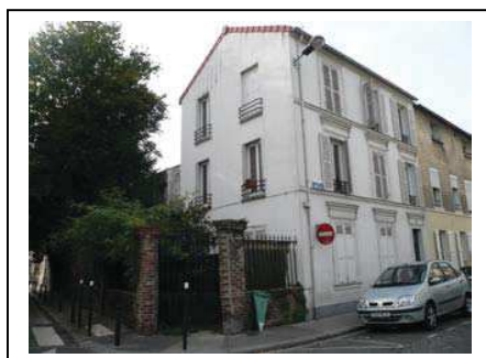
Clôture du 26 rue Pinel et du 17 rue Haguette. Croisement nord entre la rue Pinel et la rue Haguette, 26 rue Pinel. Département de la Seine-Saint-Denis, DCPSL, SPC
