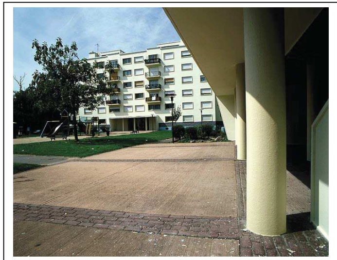
Le cœur de la cité Langevin. Photographies J.B. Vialles Département de la Seine-Saint-Denis / Région Île-de-France, ADAPG, 2008.
