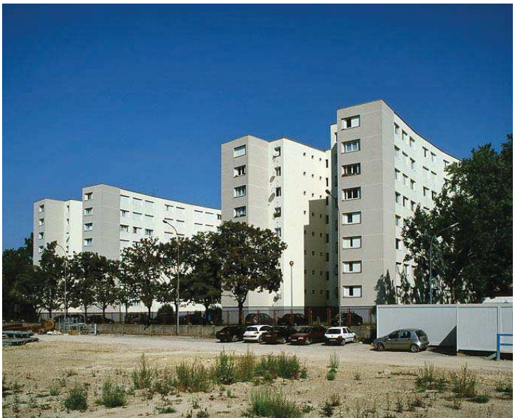
L'ensemble de la cité Guynemer. Photographie J.B. Vialles Département de la Seine-Saint-Denis / Région Île-de-France, ADAPG, 2008.
