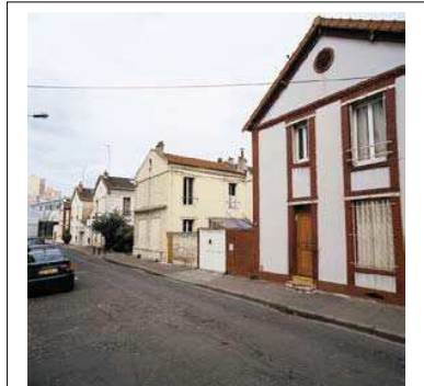
Façades rue Berne E. Jacquot, Département de la Seine-Saint-Denis, DCPSL, SPC
