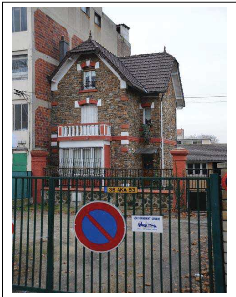
Façade principale vue depuis la rue Lénine Jacques MANGIN – UASD – Département de la Seine-Saint-Denis
