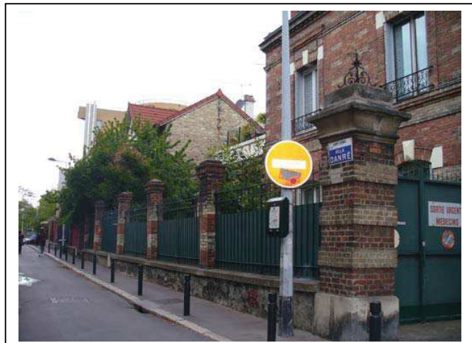
Côté impair de la villa depuis le boulevard Jules Guesde avec au 1 er plan la clôture d'origine. Au premier plan, la pile de section plus large que les autres correspond à la pile d'entrée de la voie. Celle formant son pendant côté pair a été très modifiée (voire reconstruite). Département de la Seine-Saint-Denis, DCPSL, SPC
