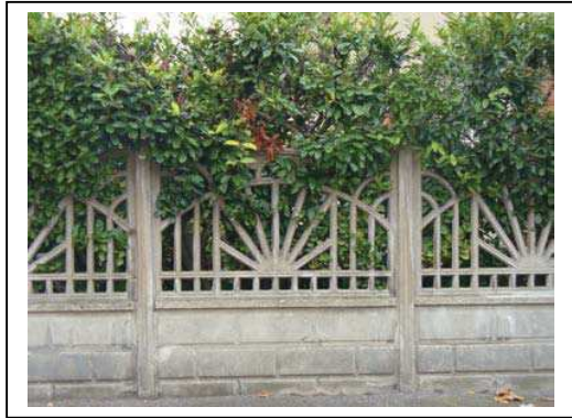
En haut et en bas : Clôtures en ciment armé (motifs géométriques n°39 et courbes n°37). Département de la Seine-Saint-Denis, DCPSL, SPC
