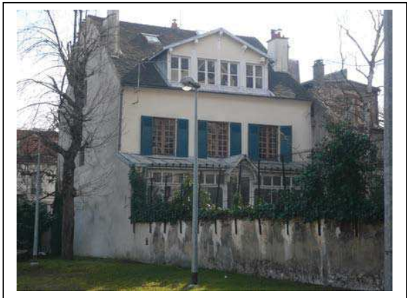
Façade postérieure visible depuis le cœur de l'îlot Condroyer. Département de la Seine-Saint-Denis, DCPSL, SPC
