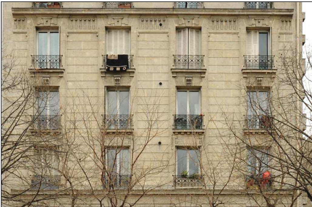
Cette façade sobre se distingue par son ordonnance classique, le soin apporté aux décors et à la qualité de la pierre. Sur la droite, on voit ici les pierres d'attente. © Jacques MANGIN – UASD – Département de la Seine-Saint-Denis
