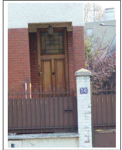
Détail de la porte du 56 rue Bonnevide Département de la Seine-Saint-Denis, DCPSL, SPC
