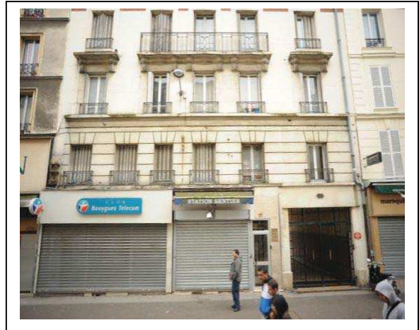
Détail des trois niveaux anciens de l'immeuble, habillés lors de la surélévation en 1932 pur s'harmoniser avec les niveaux surélevés. Département de la Seine-Saint-Denis, DCPSL, SPC
