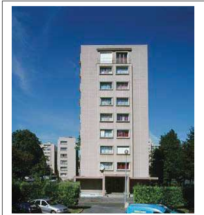
Façade sur rue Photographies J.B. Vialles Département de la Seine-Saint-Denis / Région Ile-de-France, ADAPG, 2008.
