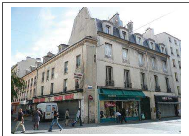
Façades principales au croisement Nord-Est des rues de la République et Gabriel Péri Département de la Seine-Saint-Denis, DCPSL, SPC
