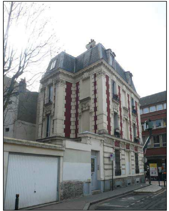
La façade postérieure côté jardin et le mur de clôture rue Emile Connoy. Département de la Seine-Saint-Denis, DCPSL, SPC
