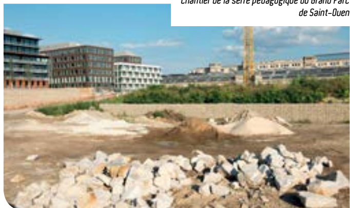
Chantier de la serre pédagogique du Grand Parc de Saint-Ouen
