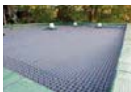
Un toit suffisamment porteur et étanche
