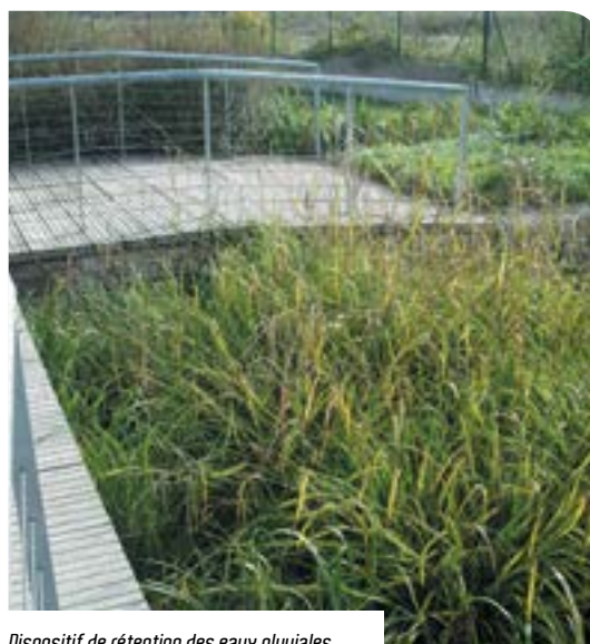
Dispositif de rétention des eaux pluviales dans le quartier des Trois Rivières à Stains
