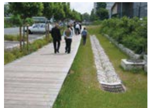
Noue de stockage à Clichy-sous-Bois
