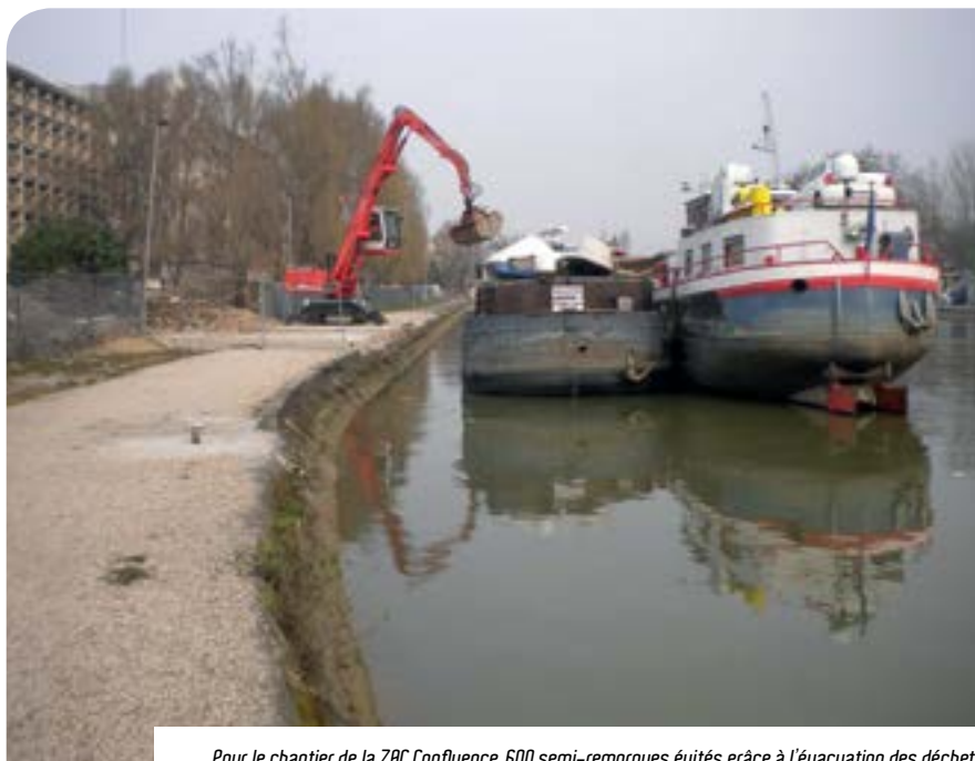
Pour le chantier de la ZAC Confluence, 600 semi-remorques éuités grâce à l'évacuation des déchets par la voie d'eau et près de 15 000 tonnes de déchets du BTP concassés, triés, et réemployés sur place
