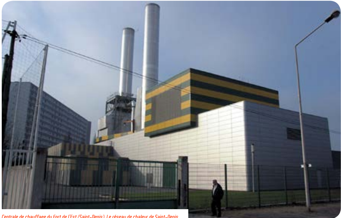
Centrale de chauffage du Fort de l'Est (Saint-Denis). Le réseau de chaleur de Saint-Denis alimente 35 000 équivalents logements avec 25 % d'énergie renouvelable (bois)
