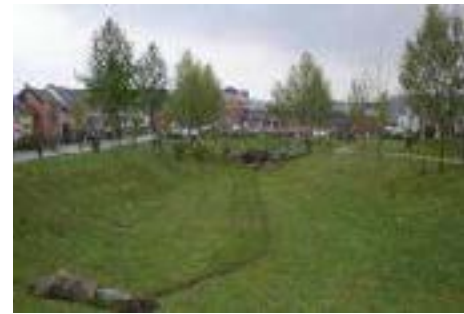
Bassin d'infiltration enherbé
