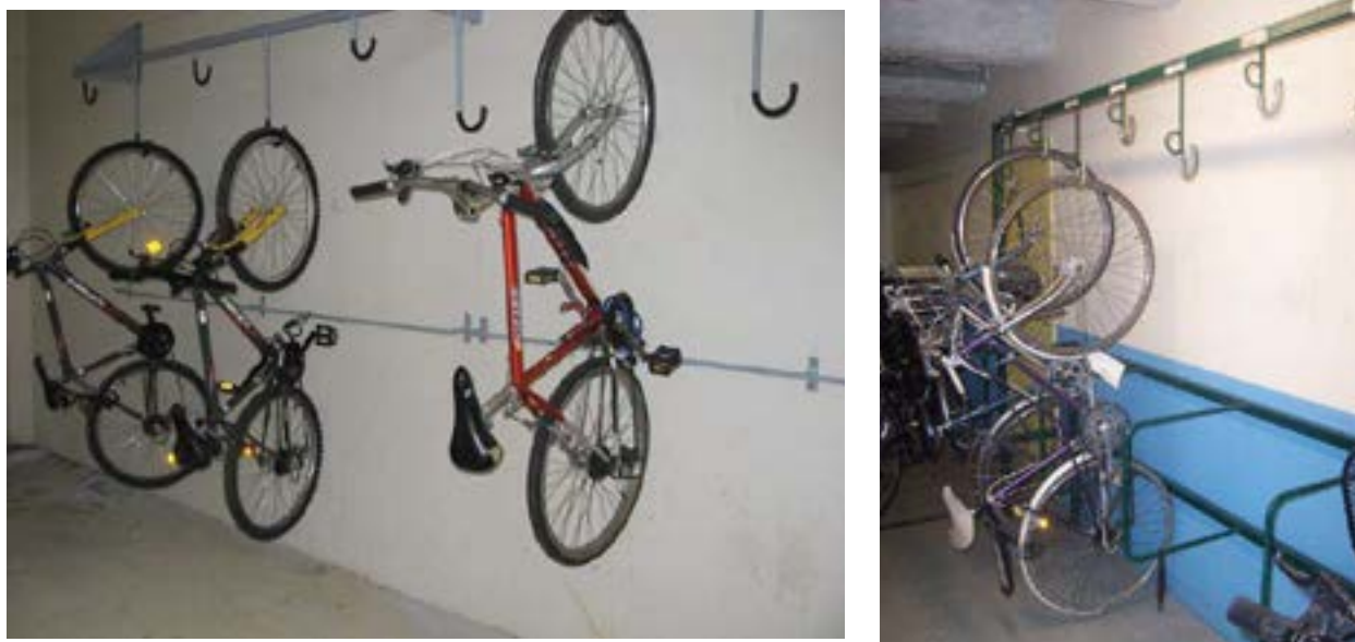
Crochets avec barre pour accrocher son cadre, et hauteur alternée (mais sans assistance pneumatique)
