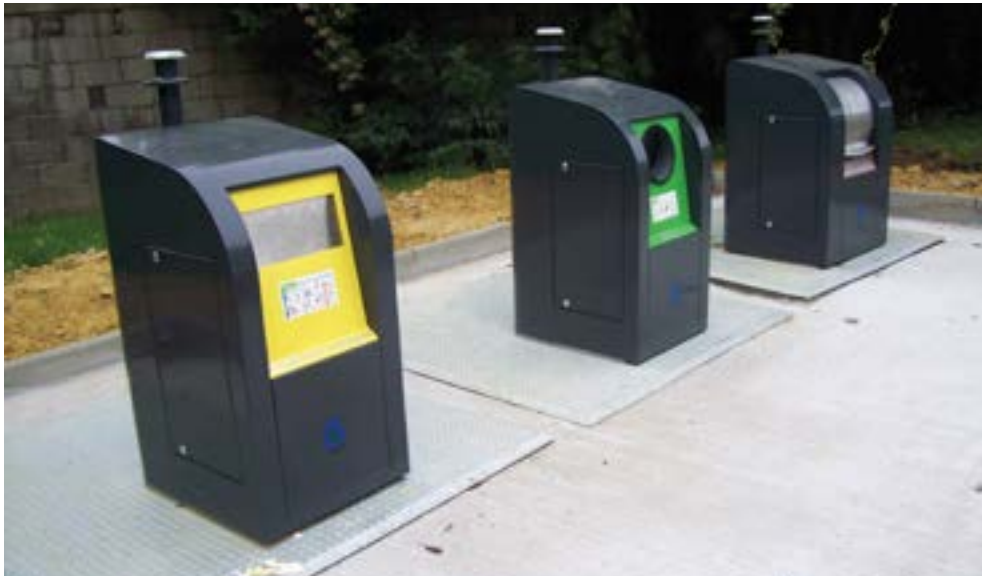
Colonnes enterrées pour les emballages, le verre, les ordures ménagères
