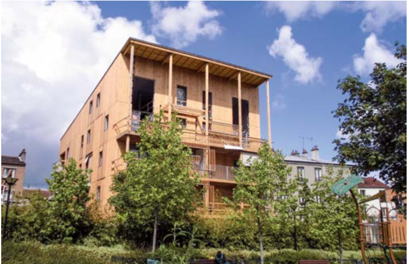
Programme de logements basse consommation en bois « Eko » à Aubervilliers
