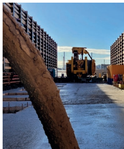
v Réalisation de la dalle de propreté et murettes guides pour la réalisation des appuis P2 - octobre 2021
