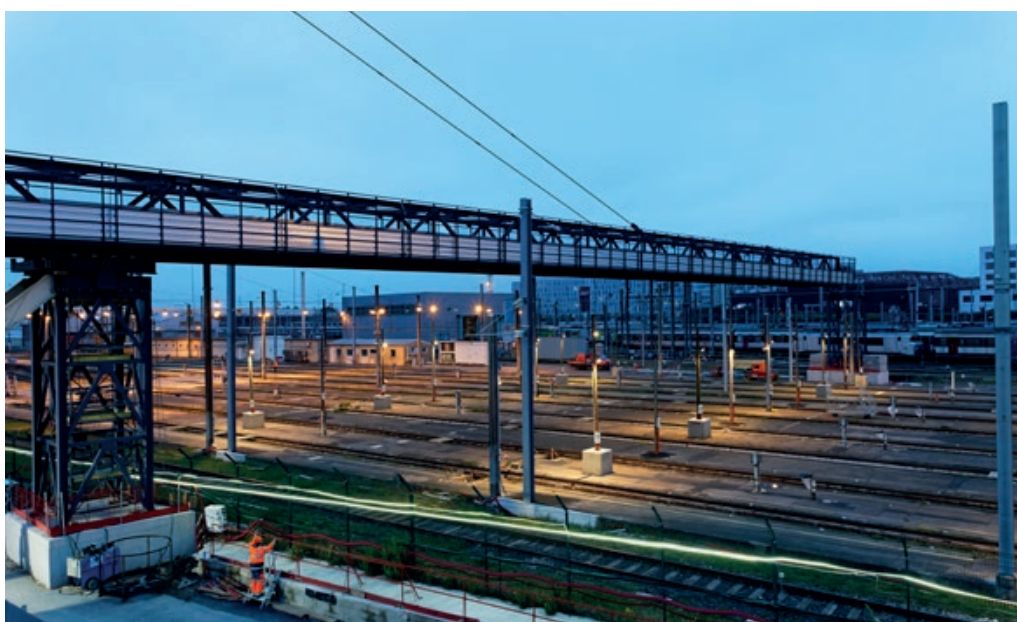
v Phase 1 du lancement de la passerelle de service - Juin 2021 ©SEM Plaine Commune Développement
