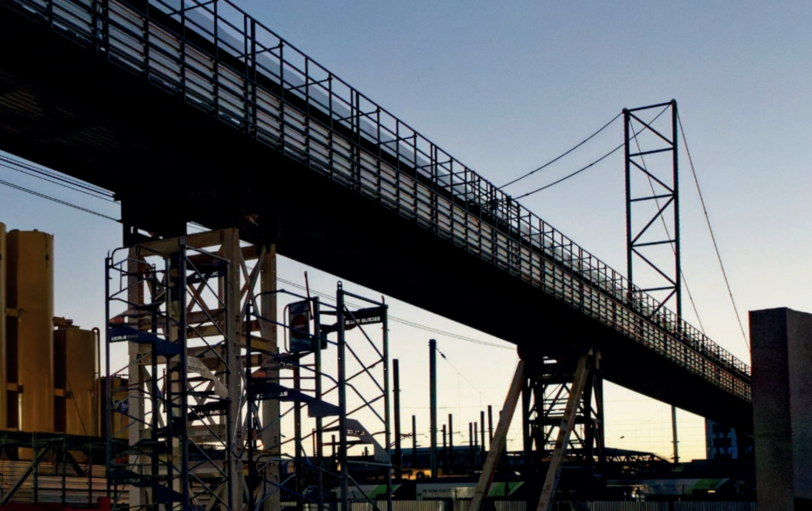
^ Phase 2 du lancement de la passerelle de service Septembre 2021 ©SEM Plaine Commune Développement
