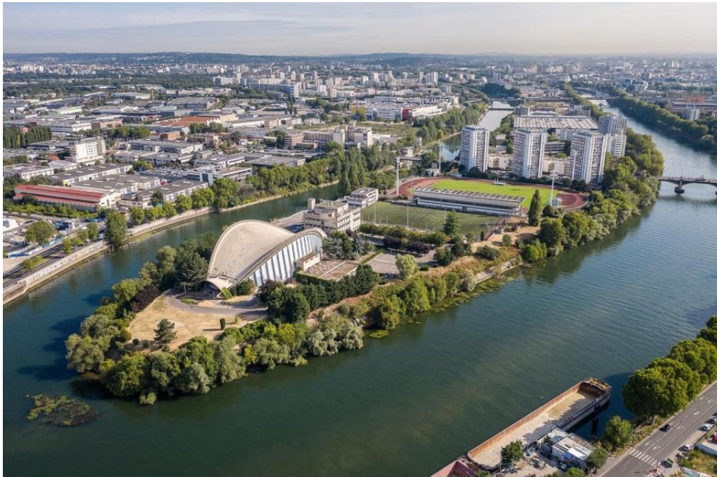
Le complexe sportif de l'île des Vannes et la Grande Nef à l'Île-Saint-Denis
