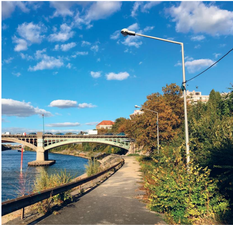
Ancienne voie express de la RD1 passant sous le pont de Saint-Ouen
