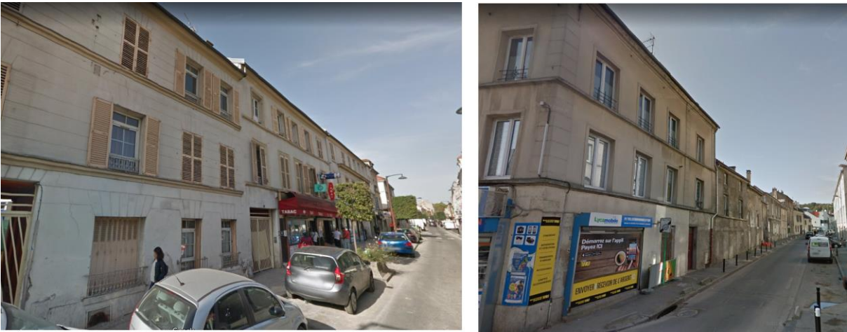
Façades des constructions rue de Paris et rue Maurice David
