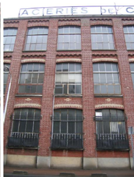
Champagnole, baies atelier largement ouvertes
