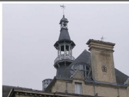
Vue rapprochée des toitures de l'H.D.V.
