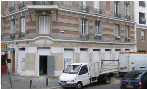
Photographie datant de 2008 montrant les travaux d'aménagement d'une nouvelle devanture : les décors d'origine du pied d'immeuble ont disparu, les volumes d'origine des ouvertures existent toujours.
