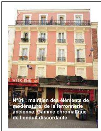
N°81 : maintien des éléments de modénature, de la ferronnerie ancienne, Gamme chromatique de l'enduit discordante.
